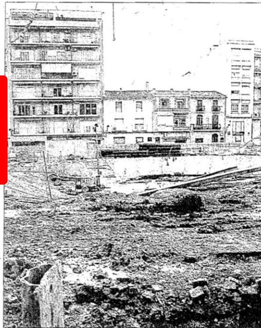
Obras de excavación en la plaza del Mercat de Algemesí. CARLOS PLA
