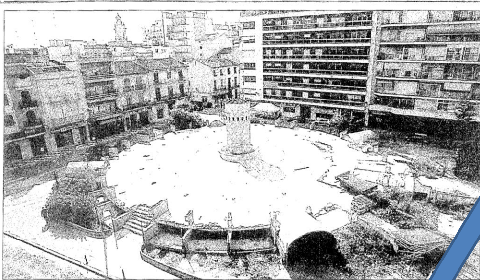
Estado que presentaba ayer la plaza del Mercat de Algemesi, donde el lunes comienzan las obras de las tres plantas subterráneas.
