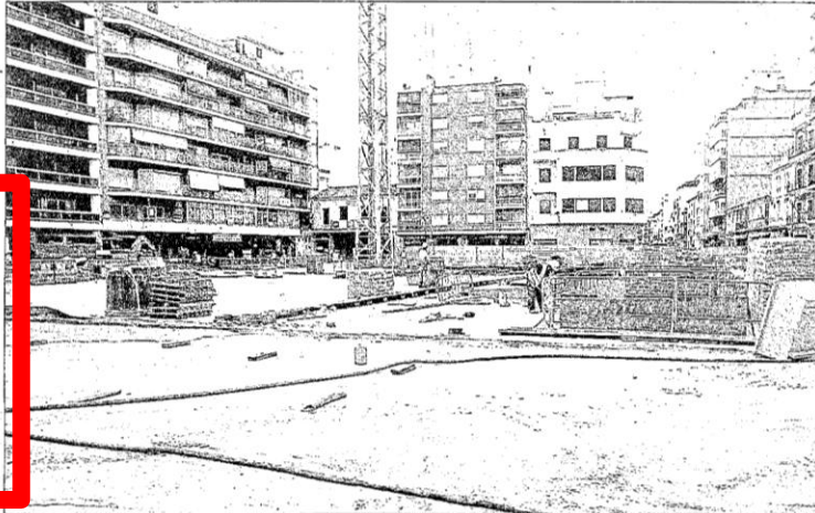
La obra de las dos plantas subterráneas en la plaza del Mercat de Algemesi casi han concluido. VICENT M. PASTOR
